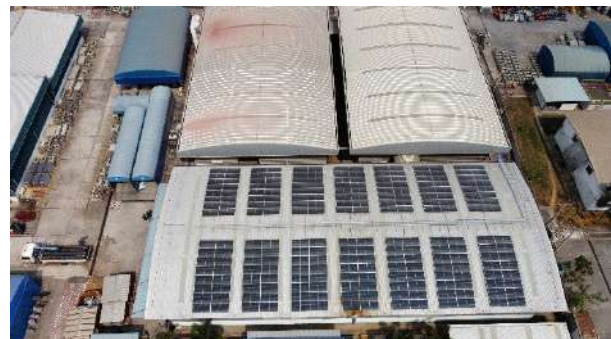
ภาพการติดตั้งเฟส 3
