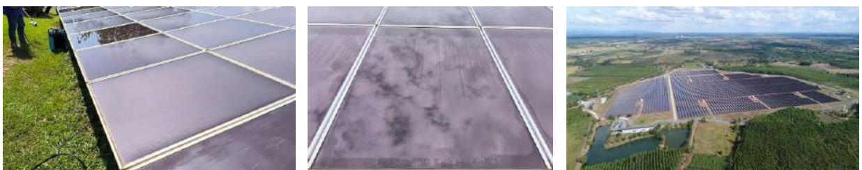
ภาพแสดงแผงโซลาร์เซลล์ที่ได้รับการขจัดคราบตะกรัน และพื้นที่โรงไฟฟ้า Q Solar 1
